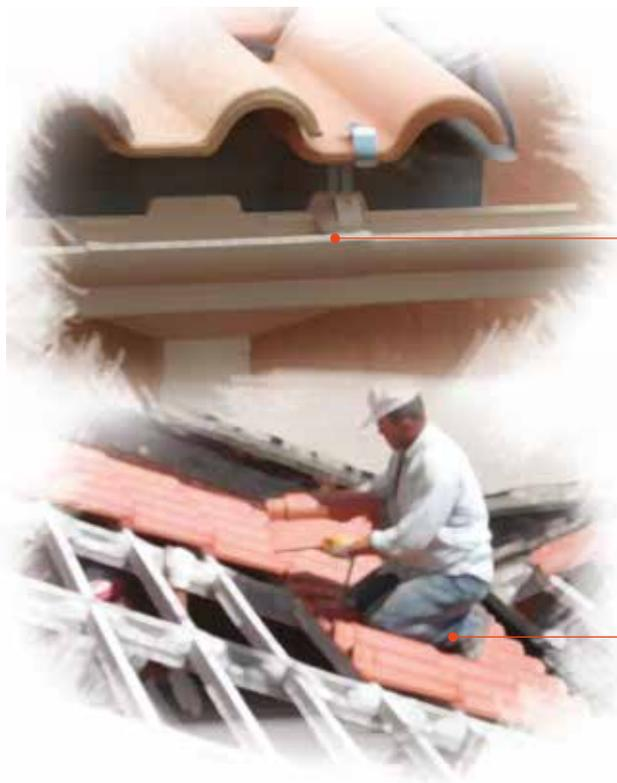
A CORRETA DRENAGEM DA ÁGUA PLUVIAL, DEVE SER CUIDADOSAMENTE EFETUADA PARA EVITAR INFILTRAÇÕES E PATOLOGIAS FUTURAS
